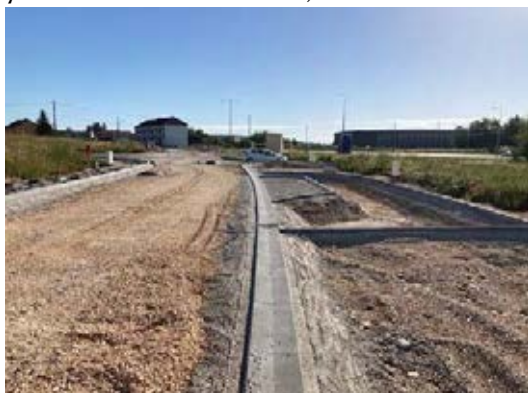
Pose des bordures trottoirs sur la prolongation de l'avenue Général de Gaulle
