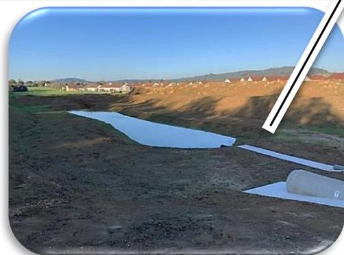
**Bassin de rétention des eaux pluviales de 547 m<sup>3</sup>**
