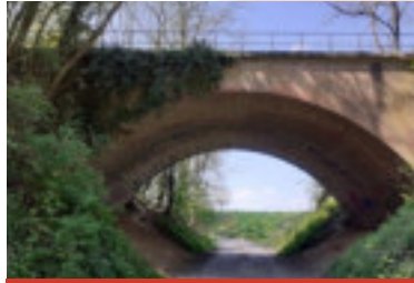
Le pont du Béart
