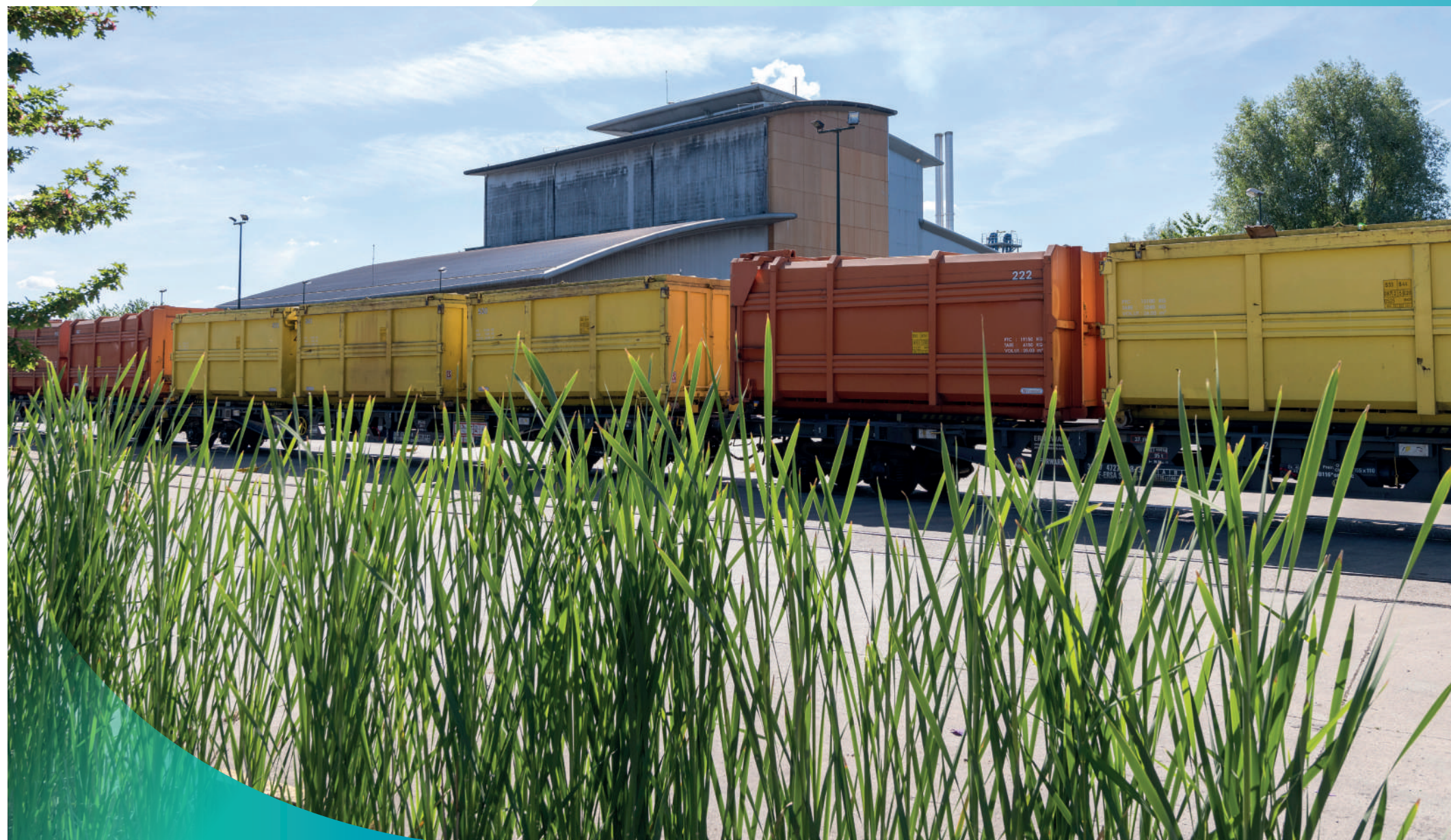
Plateforme ferroviaire de Villers-Saint-Paul
