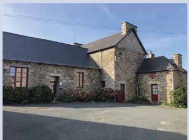
Remplacement des huisseries bibliothèque : Coût de l'opération : 61 356.30 € Subvention perçue (Conseil Départemental) : 36 760 €
