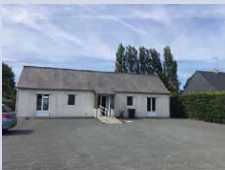
Cabinet vétérinaire : Coût de l'opération : 25 638.17 €
